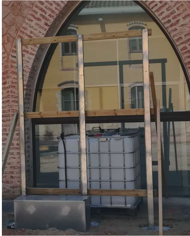
Figura 1. Soporte y depósitos del prototipo de fachada verde.
